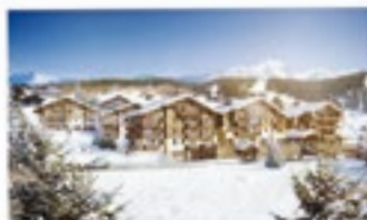
Residence de tourisme «Les Chalets d'Émeraude» aux Saixes Maître d'ouvrage : EIFFAGE Immobilier Architecte : Inhotop
